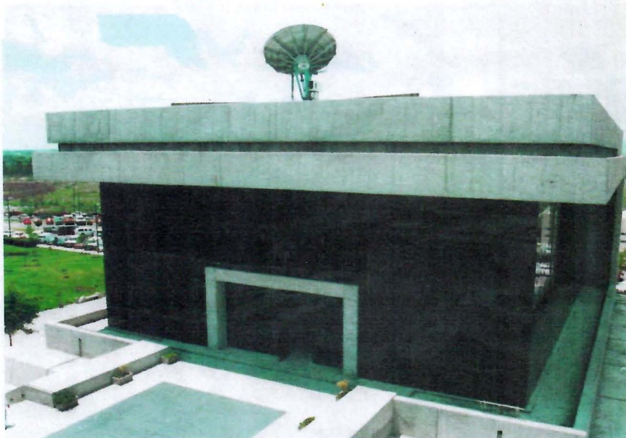
CENTRO DE CÓMPUTO
